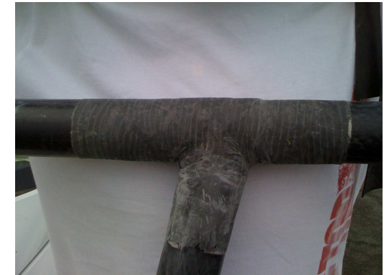
Détail n°1 entre Phase n°9 avant finition
